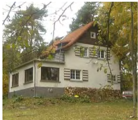
Öko-Förster Wohlleben berät die Pellet-Heizung seines Häuschens
